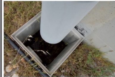
Figure 51 : gouttières actuelles autour des réservoirs
